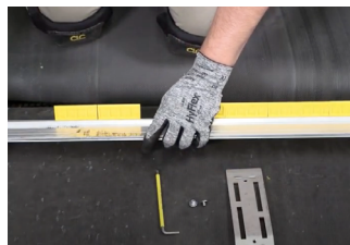
3. セグメントを支柱に固定
